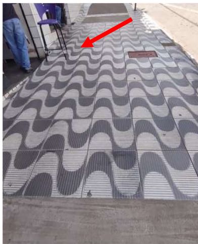
Figura 6: Passeio com revestimento tridimensional não sinalizado
