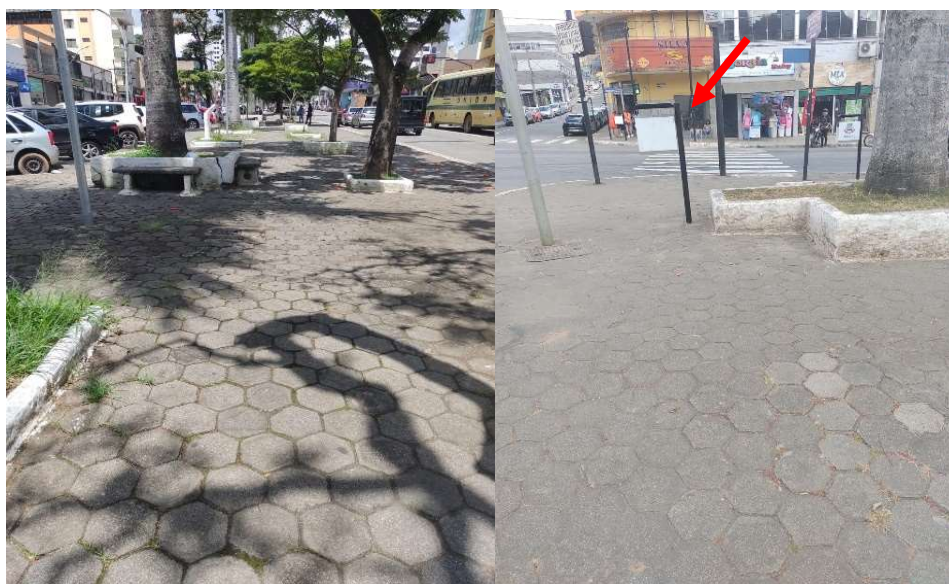
Figura 11: Trecho do canteiro que divide a Avenida
