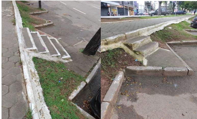
Figura 10: Escadas existentes no canteiro central
