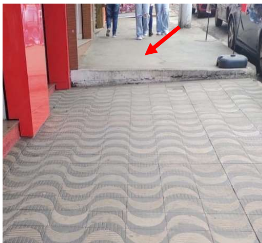
Figura 7: Passeio interligado por degraus isolados
