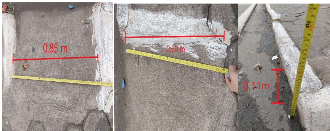
Figura 9: Rampa de acesso do passeio para a via (Largura= 0,85m, Comprimento= 0,60m, Altura= 0,11 m respectivamente)
