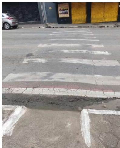
Figura 13: Rebaixamento do passeio com faixa elevada
