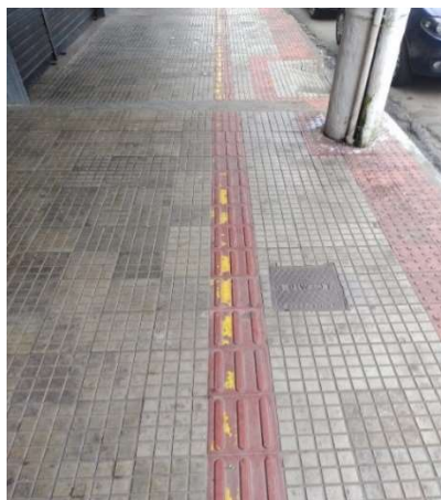
Figura 4: Sinalização tátil e visual de indicação de sentido de circulação e de obstáculos (Poste e rampa)
